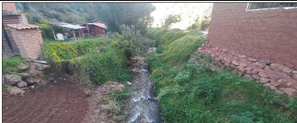
FIGURA N°01: TRAMO CRÍTICO EN LA QUEBRADA RAYAN, DISTRITO DE TARAY, PROVINCIA DE CALCA - CUSCO, SE APRECIA EL CAUCE COLMATADO Y LLENO DE VEGETACION.
