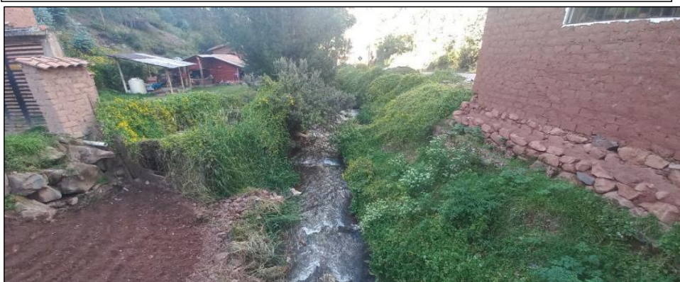
FIGURA N°02: TRAMO CRÍTICO EN LA QUEBRADA RAYAN, DISTRITO DE TARAY, PROVINCIA DE CALCA - CUSCO, SE APRECIA EL CAUCE COLMATADO.
